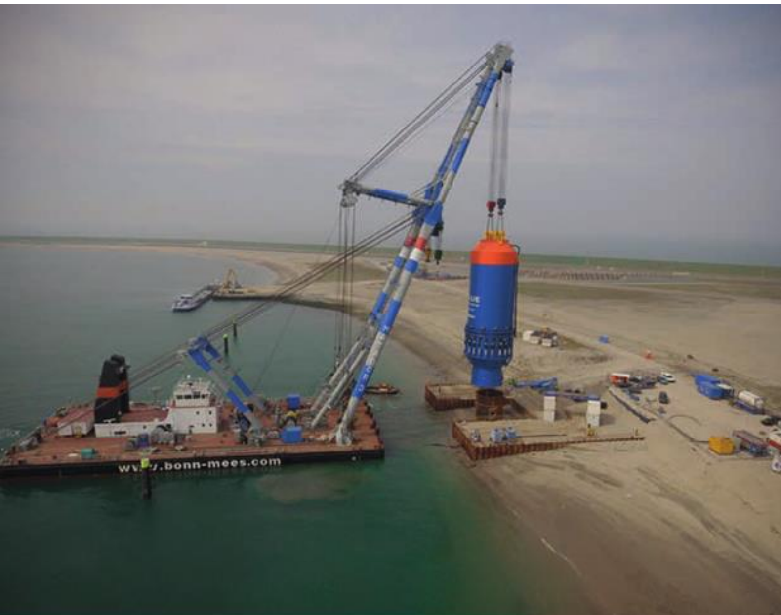
Tijdens een test op de Tweede Maasvlakte liet offshorebedrijf Fistuca een met water gevulde, 30 m hoge cilinder neerkomen op een funderingspaal.
